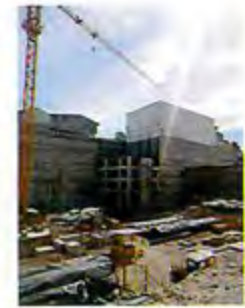
OBRAS DE TERRACERIA Y DE PROTECCIÓN AL TERRENO (MURO SOILNAILING), VISTAS VARIAS DEL TERRENO Y OBRAS EN EJECUCIÓN
