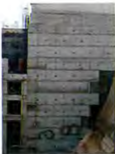
OBRAS DE TERRACERIA Y DE PROTECCIÓN AL TERRENO (MURO SOILNAILING), VISTAS VARIAS DEL TERRENO Y OBRAS EN EJECUCIÓN
