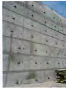
OBRAS DE TERRACERIA Y DE PROTECCIÓN AL TERRENO (MURO SOILNAILING), VISTAS VARIAS DEL TERRENO Y OBRAS EN EJECUCIÓN
